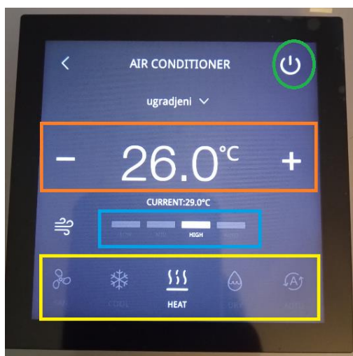
Slika 2.4 Prikaz dodirnog panela za upravljanje klimatizacijom
